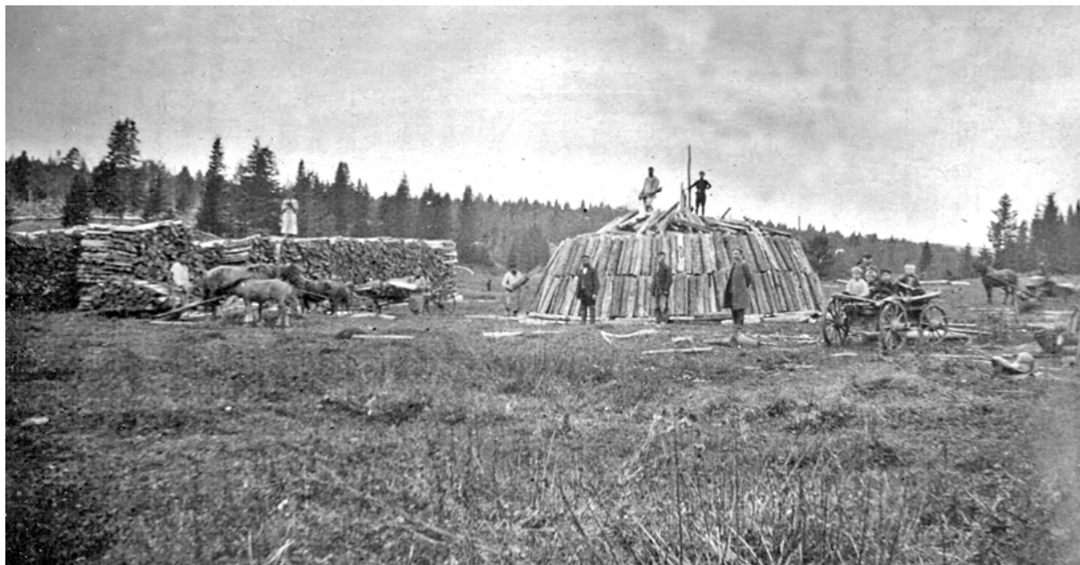
Сборка «кабана» для выжига древесного угля
