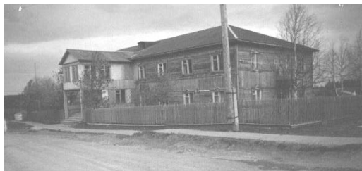
На фото: Контора «Лескора» (не сохранилась).
