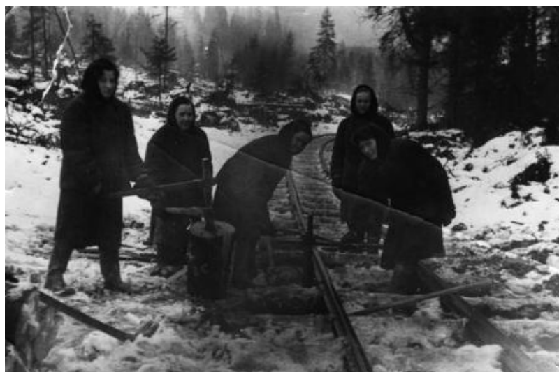
Участие женщин в строительстве узкоколейки.
