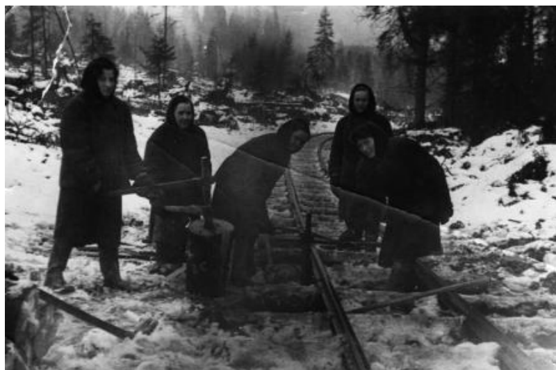
Участие женщин в строительстве узкоколейки.
