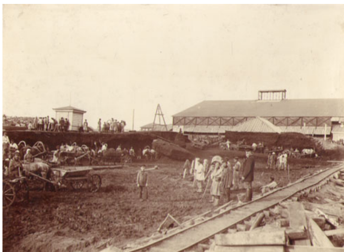
1903 г. Подготовка площадки для строительства нового цеха ЛМЗ
